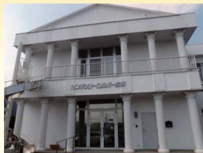
介護付有料老人ホーム センチユリーシルバー佐野様 栃木県佐野市大橋町1416-5
